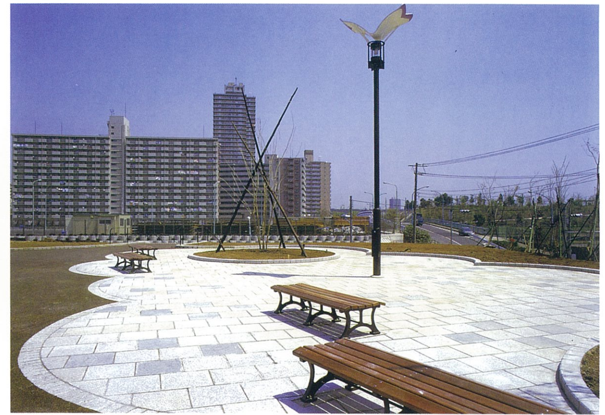
江戸川区内緑地舗装敷石・縁石
